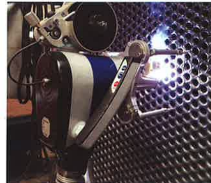
Beispiel für das Einschweißen bündiger Rohre mit einem Polysoude Orbitalschweißkopf TS 8/75
