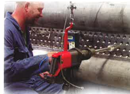
Einschweißen zurückgesetzter Rohre in einen Rohrboden
