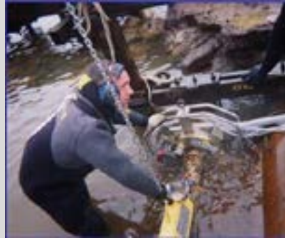
Zerlegen von Rohren unter Wasser
