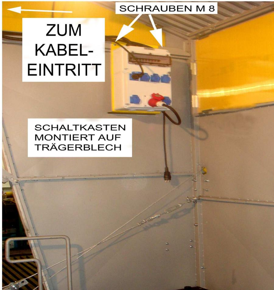
DER SCHALTKASTEN IST AUF EINEM TRÄGERBLECH MONTIERT UND WIRD MIT SCHRAUBEN M 8 AN DER GIEBELWAND MIT DEN BEIDEN ÖFFNUNGEN FÜR KABEL AUS - UND EINTRITT VERSCHRAUBT. ZULEITUNGSKABEL WIRD NACH AUSSEN GEFÜHRT.
