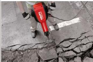
Einfaches und rasches Abtragen von Asphalt im Straßenbau sowie bei Kanalreparaturen und -wartungsarbeiten.
