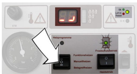
Bild: Programmwahltaster auf „I“ oder „II“ stellen
