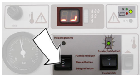
Bild: Programmwahlschalter auf „0“ stellen
