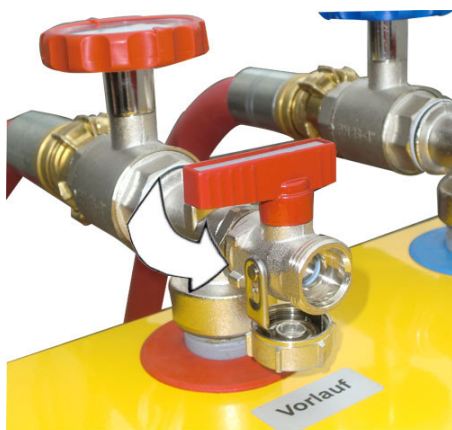
Bild: Kugelhahn der Entlüftungsleitung öffnen
