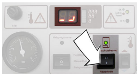
Bild: Heizungsschalter auf „I“ drücken
