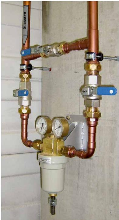
Er wird überall dort verwendet, wo große Gasmengen benötigt werden z. B. beim Flammstrahlen, Brennschneiden über 300 mm Materialstärke oder Wärmen oder als zentraler Bestandteil von Druckminderstationen. Die große Membranfläche garantiert hohe Regelgenauigkeit und konstanten Arbeitsdruck.
