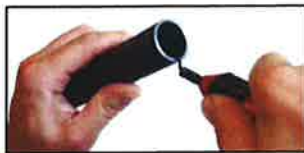
Abbildung 3: Entgraten der Rohrenden
