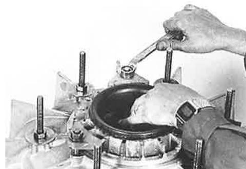
Die Pumpe umdrehen und die kompletten Federn, bestehend aus Abstandshülsen, Gummibuchsen und Spiralfedern, aufsetzen.
