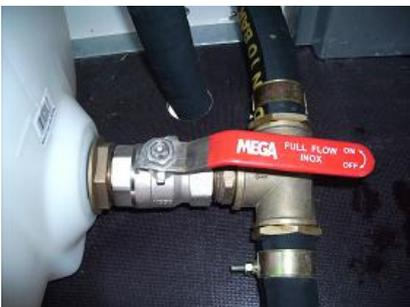
6. Bei ausreichender Liefermenge muss der Tank nicht befüllt werden, ansonsten: Kugelventil zum Wassertank öffnen, Tank langsam befüllen und beobachten.
