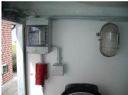
**Anschlusskabel - CEE Kupplung 400 Volt, 16 A mit Wandstecker / Verteilung verbinden und Stromversorgung des Prüfhänger herstellen.**
