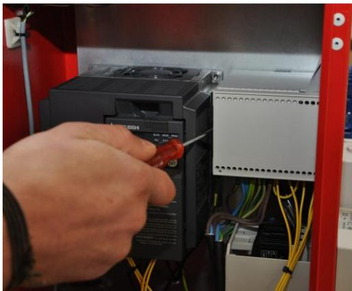
Beim Wechseln der Sicherung muss zunächst die Stromzufuhr abgeschaltet werden. Mit Hilfe eines Schlitzschraubendreher kann man den Deckel des Sicherungskasten an der linken Seite lösen und den Deckel abnehmen.
