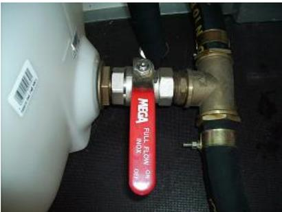
4. Kugelventil zum Wassertank im Prüfhänger schließen.
