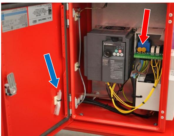
Die Sicherung befindet sich hinter den zwei ründlichen Varistoren und kann nach oben herausgezogen werden (siehe roter Pfeil). Hierfür kann ebenfalls ein Schlitzschraubendreher hilfreich sein.
