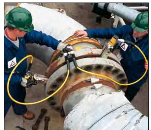
▼ Zwei FSH-14 Spreizer im Einsatz mit Enerpac Handpumpe, Schläuchen und AM-21 Doppelabsperrventile.
