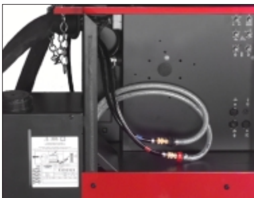
Fig. 22 Montage des câbles et raccords
