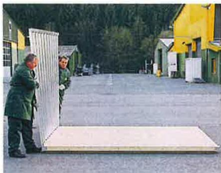
1. Bodenelement ausrichten...
